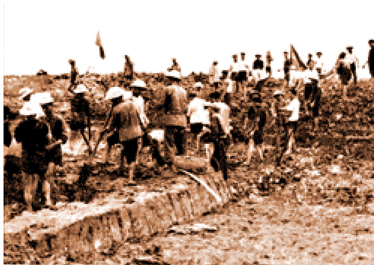
Trên công trường Bắc Hưng Hải (1958)
